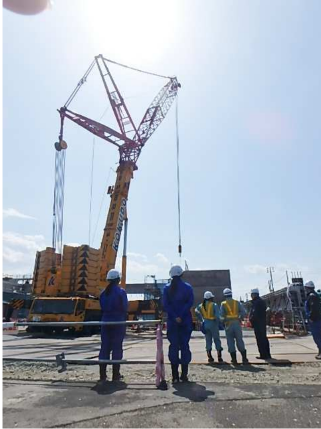
650 t クレーンによる架設見学
