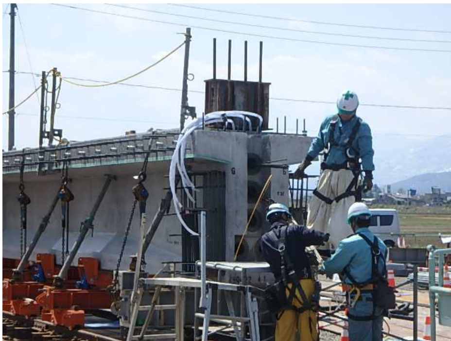
5セグメント桁の緊張（縦締め）作業見学
