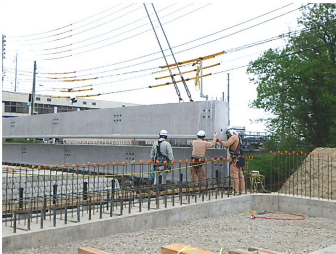
上越市 戸野目川下流橋 450 t クレーンでの架設見学
