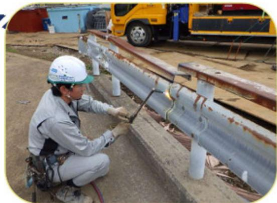
↑ 高欄撤去 ガス切断 ↑
